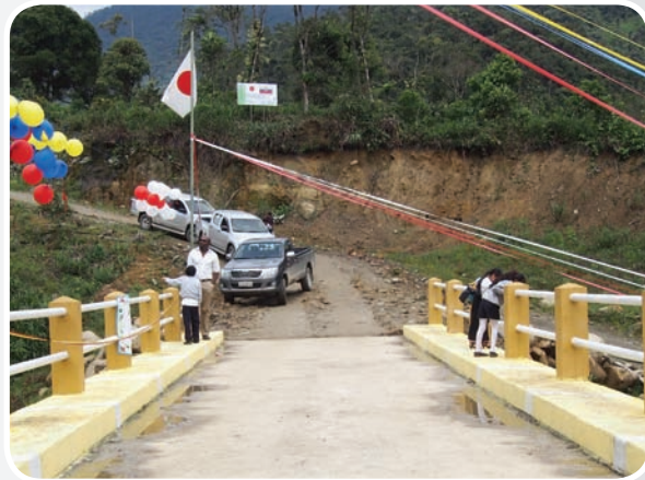
Proyecto de construcción de puente sobre el Río Gulac
